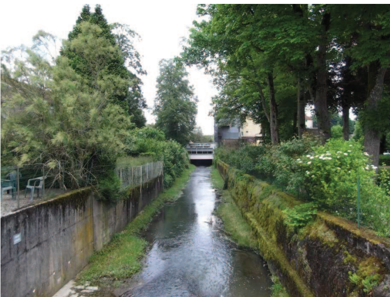
Ruisseau de Borne depuis l'avenue Maréchal de Lattre de Tassigny / Vue de l'entrée du tronçon couvert
